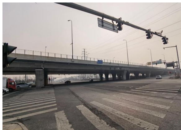
照片 4-2 兴亦路桥
