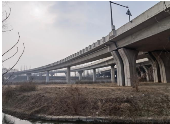
照片 4-4 京台高速跨新风河桥
